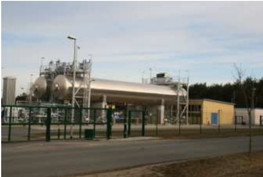
CO 2 -Verpressungsanlage Mahlsdorf-Maxdorf
